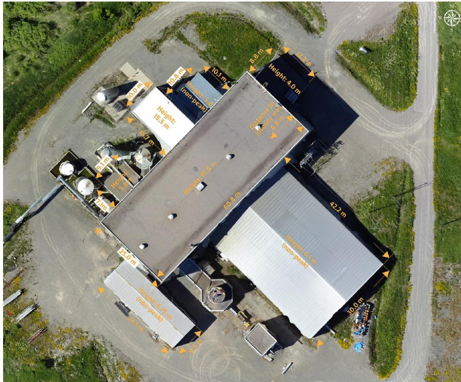
Abbildung 1 - Luftaufnahme der First Cobalt Raffinerie
