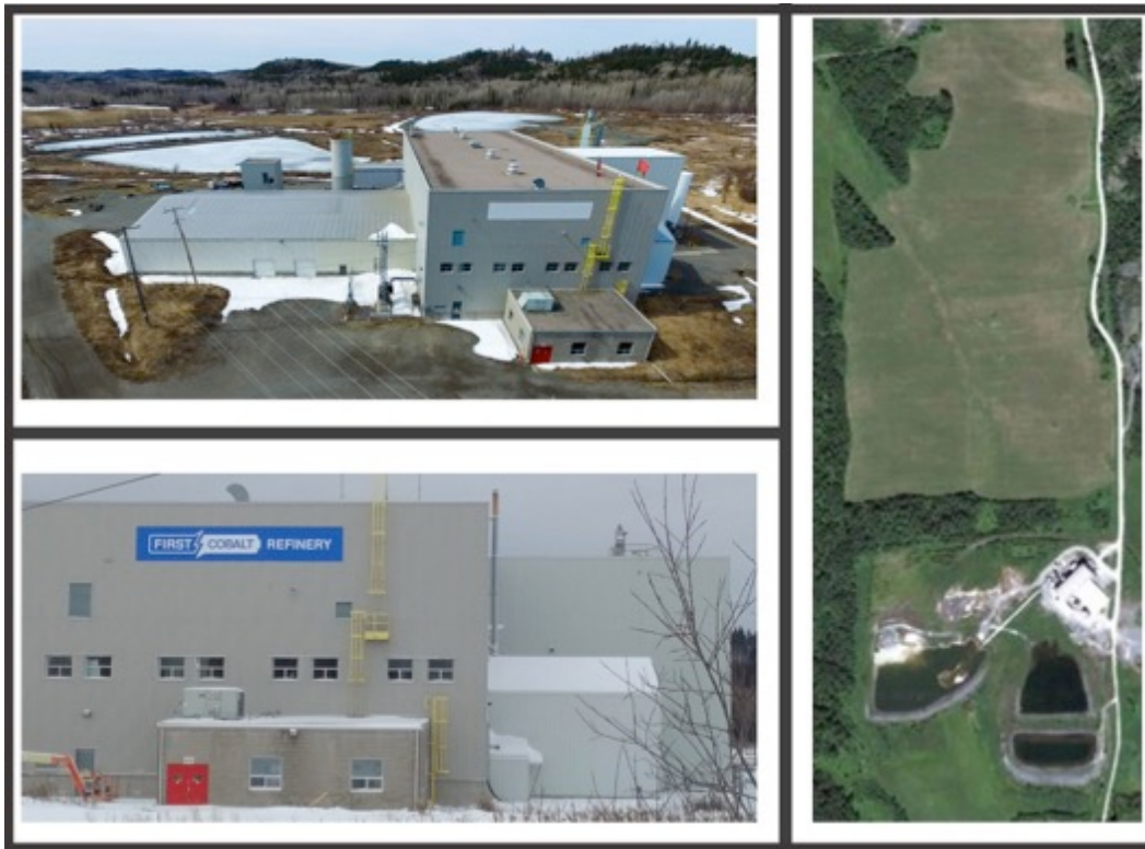
Bild 1. Außen- und Grundstücksfläche der ersten Kobaltraffinerie (Ontario, Kanada)
