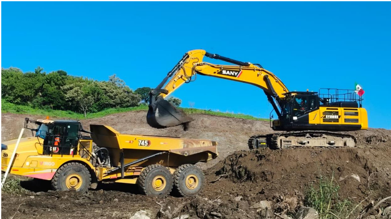
Abbildung 1 – Erdarbeiten schreiten voran
