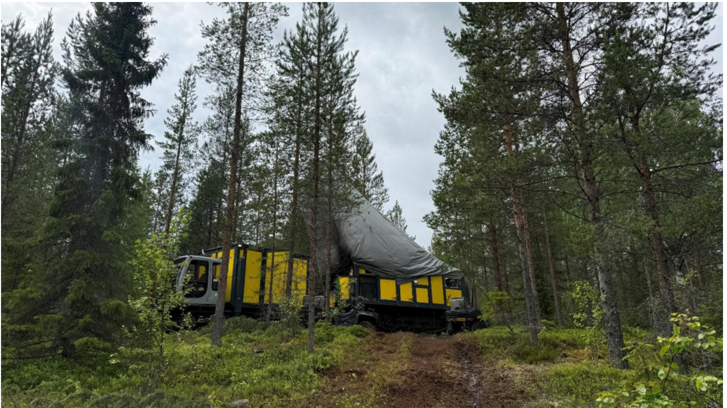
Foto 1: Aufstellung der Diamantbohranlage ST2607 am Prospektionsgebiet Stavaträsk in Nordschweden.
