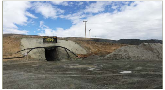
Fire Creek Mine, Quelle: Eigene Bilder
