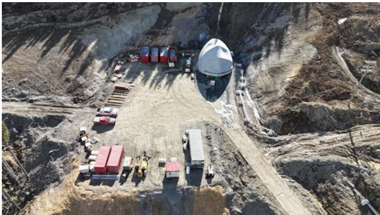
Abbildung 5: Entlüftungsschacht in der Lowhee-Zone.
