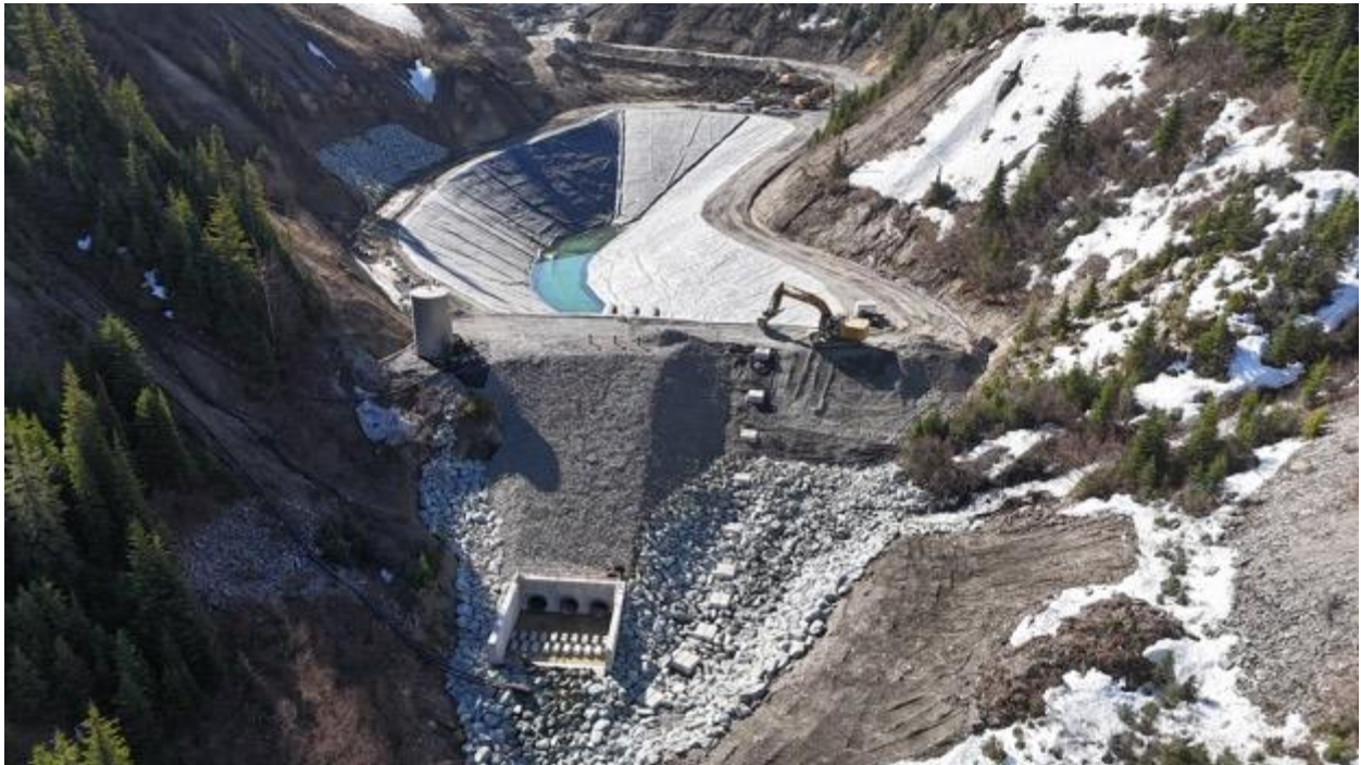
Abbildung 2: Sedimentationsbecken (SCP): Verlegte Auskleidung und Einbringen von Zuschlagstoffen.
