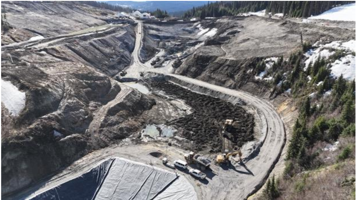
Abbildung 1: Luftaufnahme der Halde für Abraum (WRSF) mit den laufenden Arbeiten.
