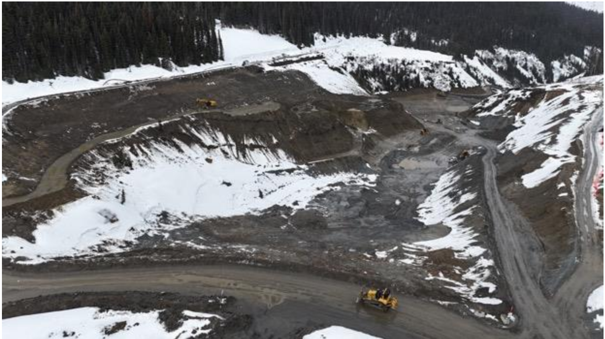
Abbildung 1: Luftaufnahme der Haldenaufbereitungsanlage (WRSF).
