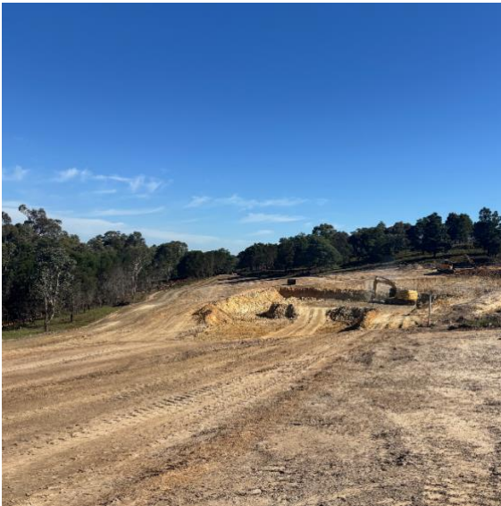
Abbildung 1. Erdarbeiten für den Box-Cut, 30. April 2026.
