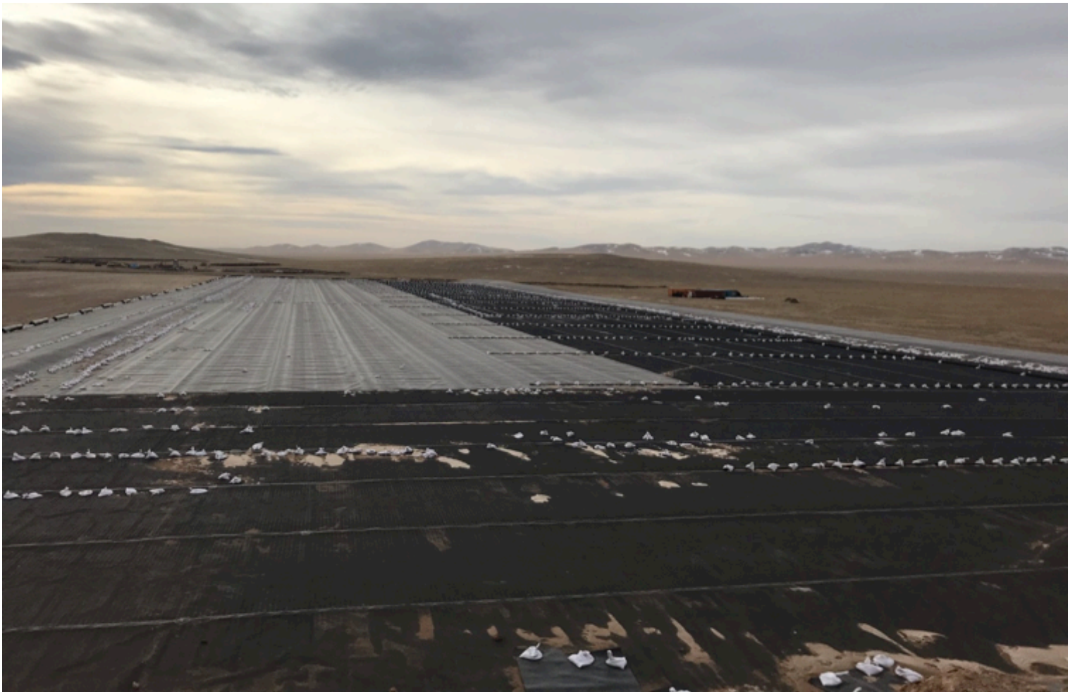
Zelle 1 fertig gebaut
